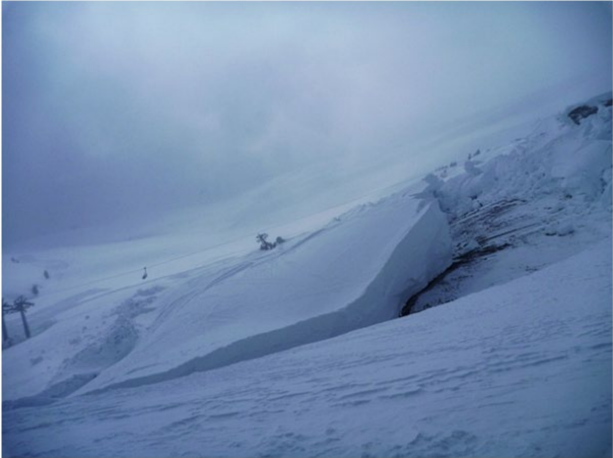
Abb. 4: Ein Bauwerk wie z.B. eine Seilbahnstütze, die sich im Einflussbereich der gleitenden Schneedecke befindet, wird durch sehr grosse Schneedruckkräfte belastet. Bei der Sesselbahn Lungern – Schönbühl wurde dadurch eine Stütze umgedrückt. Der resultierende Schneedruck dürfte mehr als 100 Tonnen betragen haben. Die bis zu 8 m mächtige Schneetafel hat sich um rund 25 m in Talrichtung verschoben (7. Februar 2012; Photo SLF/S. Margreth)
