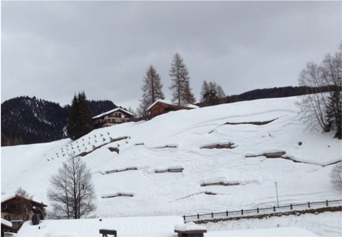
Abb. 5: Schneegleiten kann durch Gleitschneeverbauungen wie Dreibeinböcke oder Stützwerte verhindert werden. In der vorliegenden Situation sind in den verbauten Gebieten keine Gleitschneelawinen angebrochen (Wiesen, Januar 2012; Photo SLF/S. Margreth)
