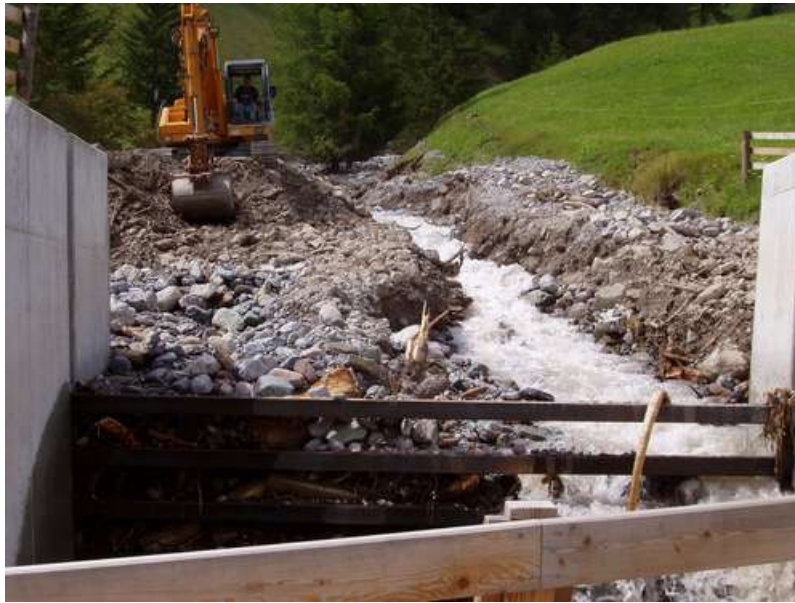
Abb. 3: Aufräumarbeiten im Geschiebefänger oberhalb von Davos Glaris (GR) nach einem Murgangereignis vom 07.08. (Foto: SLF/C. Gwerder, 10.08.2004)
