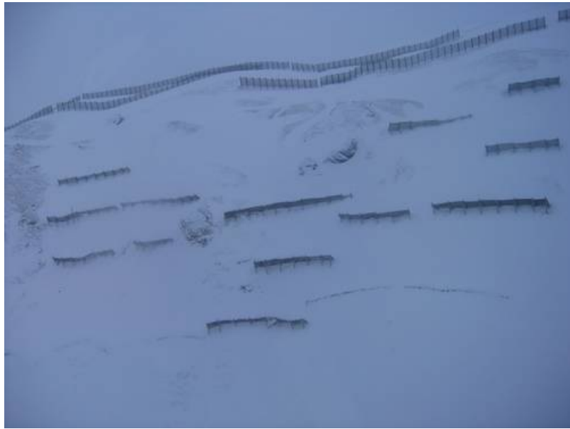
Abb. 12: Diese Lawine riss in der Lawinverbauungen am Muot da l'Hom oberhab von Ftan, Unterengadin (GR) an und beschädigte diese. Die Verbauung war aber durch die Hangrutschung bereits geschwächt (Foto: J. Kindschi, 19.12.2005).
