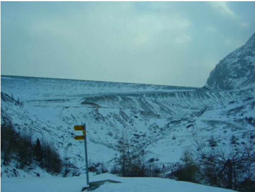
Staumauer Mattmark par temps de foehn le 26 janvier 2006 (Photo: G. Sanga, 26.01.2006).
