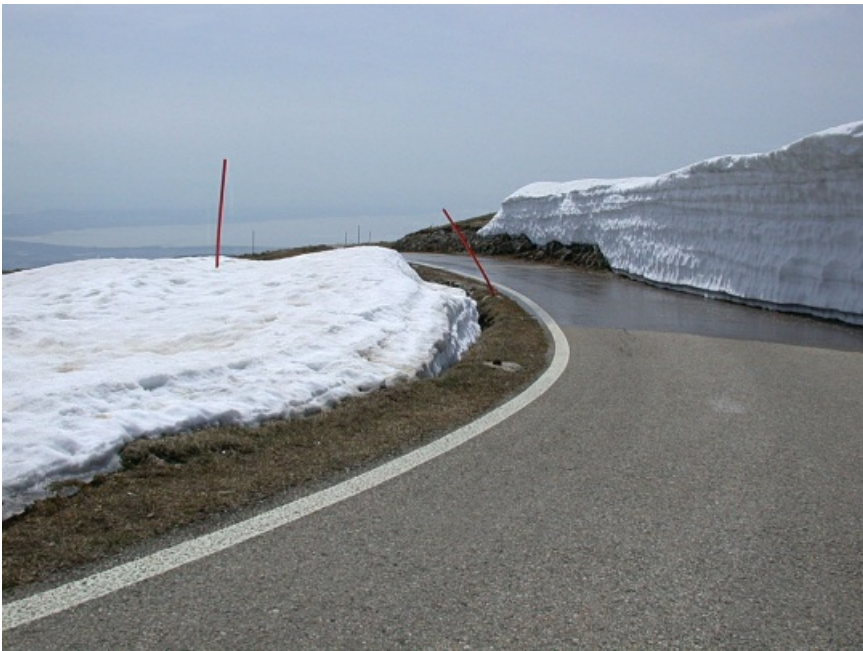
Versorgungssträsschen zum Sendemast am Gipfel des Chasseral (1607 m) im Berner Jura: im Profil eine durchfeuchtete «saisonale» Schneeverfrachtung auf der südwestlichen Gipfelkrete. Am Jurasüdfuss zeigt sich der Lac de Neuchâtel (Foto: R. Ohmayer, 02.05.2006).
