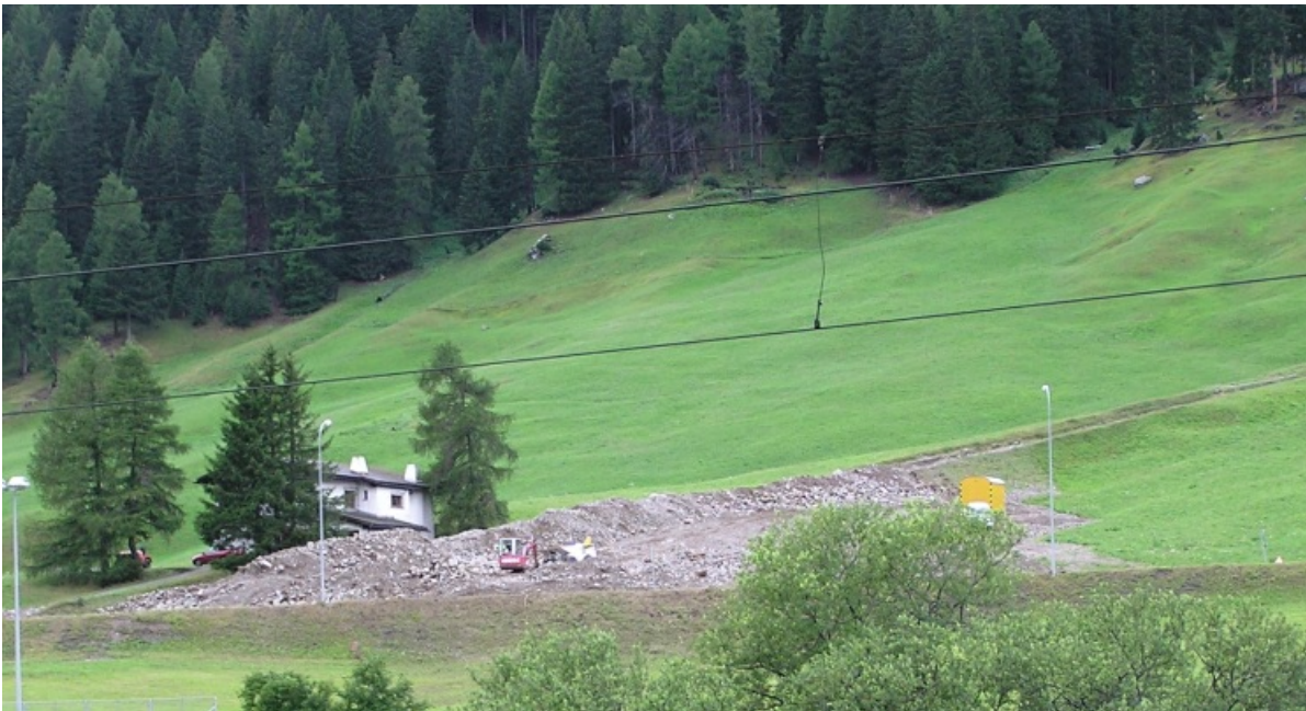
Dieser Murgang verschüttete die Kantonsstrasse bei Davos Richtung Tiefencastel. Verursacht wurde er durch kurze, aber sehr intensive Gewitterniederschläge am 28.07. (Foto: SLF/C. Pielmeier, 04.08.2006).
