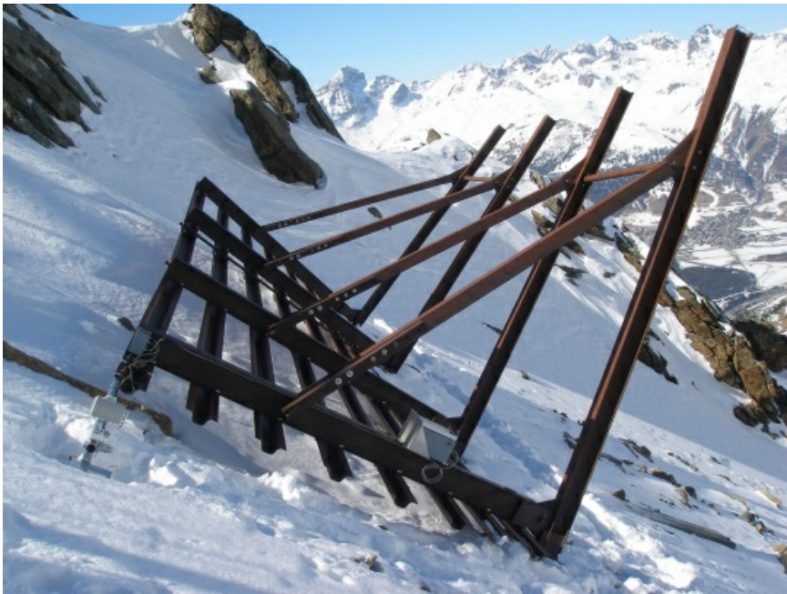
Eine Lawinerverbauung sollte den Schnee am Hang zurück zu halten. Diese Verbauung am Schafberg oberhalb von Pontresina, GR wurde im Januar von einer Sturmböe hangaufwärts gekippt. Das war nur möglich, weil zu dieser Zeit kaum Schnee lag (Foto: SLF/M.Philipps, 16.03.2007).
