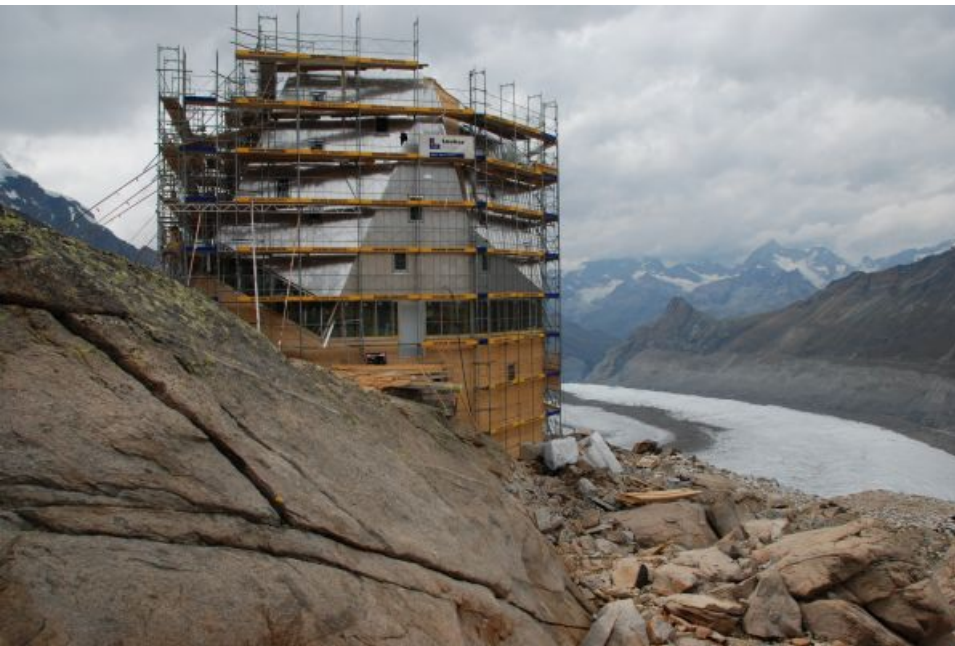
Der überdurchschnittlich warme und trockene August brachte ideale Bedingungen für den Bau der neuen Monte Rosa Hütte, Zermatt, VS (Foto: SLF/M. Phillips, 24.8.2009).
