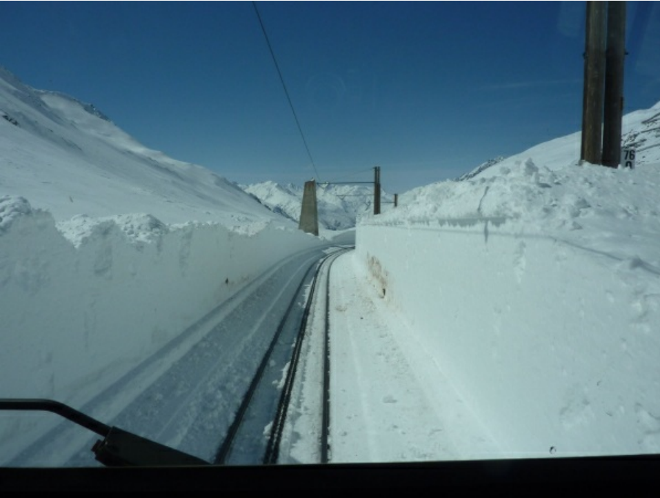
Dienstag, 06.04.: .... Das Bahntrasse nach der Räumung (Foto: M. Levy).
