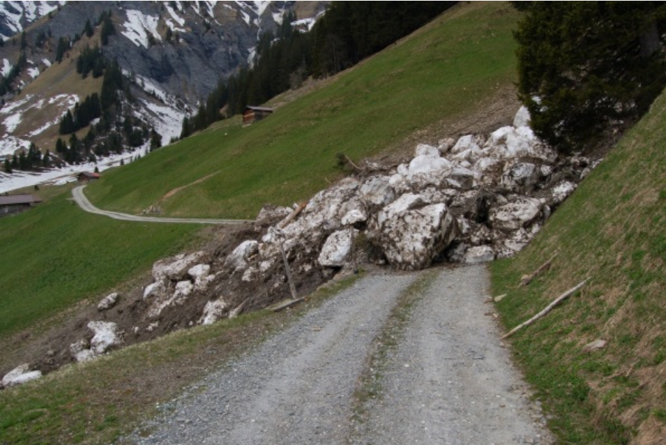
Ablagerung der Lawine im Tschentetal. Die Schnee- und Erdmassen haben mitten im Grünen auf 1430 m eine Strasse verschüttet (Foto: Abteilung Naturgefahren BE, 30.04.2012).
