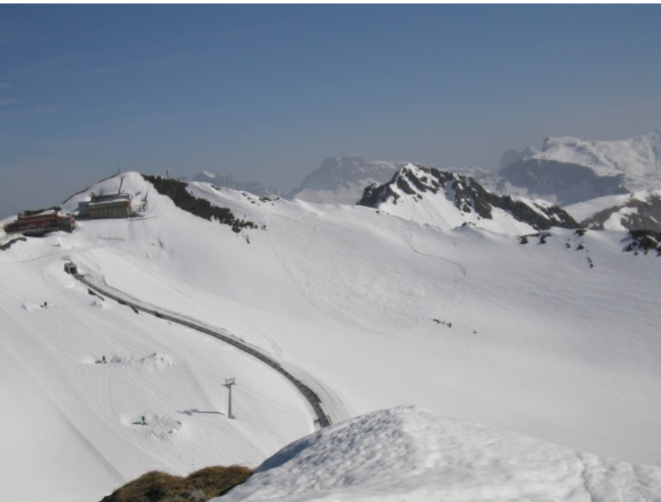
Forschung in passender Umgebung: Das alte Institutsgebäude des SLF auf dem Weissfluhjoch ob Davos (GR) und daneben eine durch Personen fernausgelöste Schneebrettlawine (Foto: SLF/L. Dürr, 30.04.2012).
