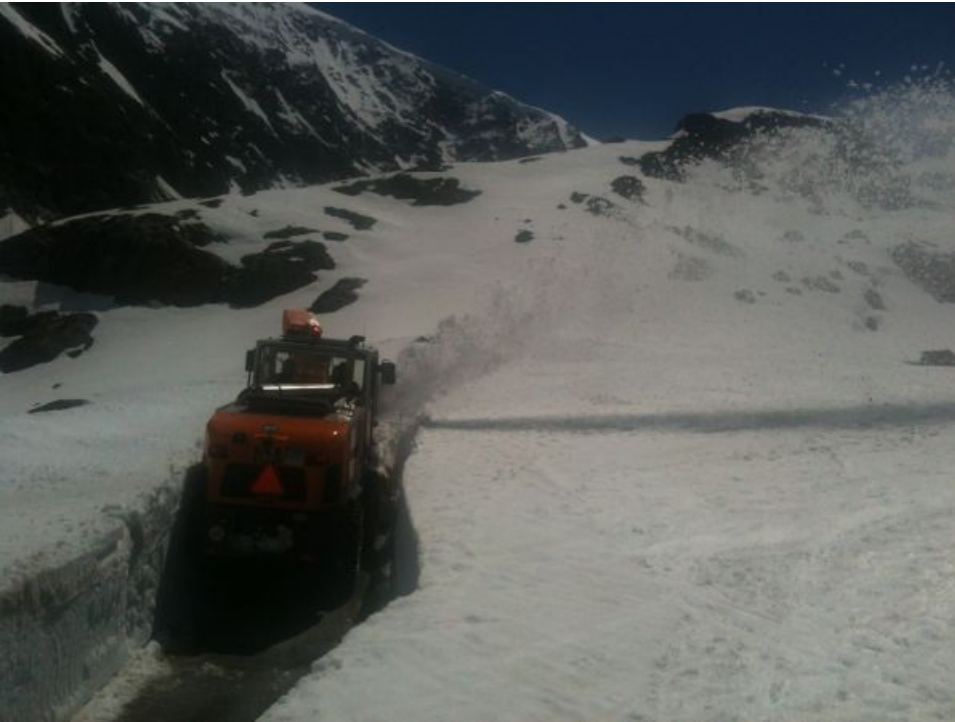
Obwohl dieses Bild von Räumung der Sustenpassstrasse nicht aus dieser Wochenberichtsperiode stammt, ist es trotzdem repräsentativ für die Arbeit der Tiefbauämter in der zweiten Maihälfte (Foto: S. Maas, 14.05.2012).
