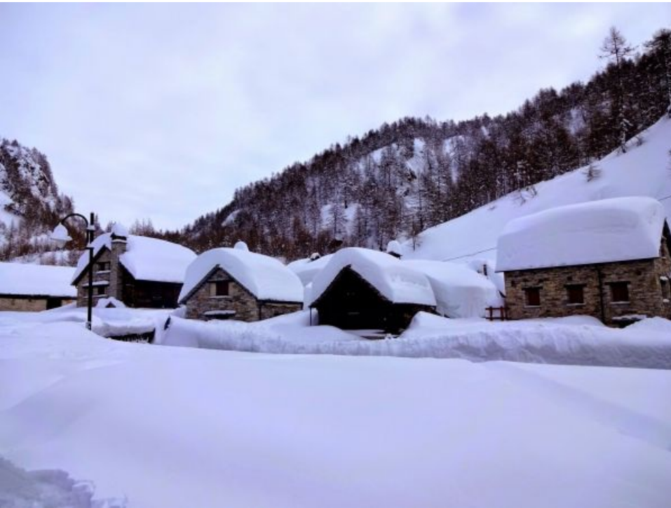
Viel Neuschnee auf den Dächern in Crampio (Valle Dèvero, IT) auf rund 1760 m (Foto: G. Voide, 22.02.2015).
