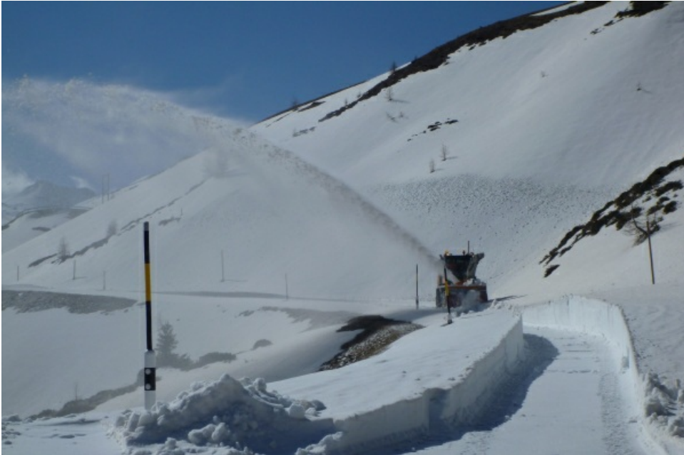
Schneeräumungsarbeiten am Umbrailpass (2501 m, Val Müstair, GR). Bis auf diese Höhe ist die Schneedecke isotherm und durchfeuchtet (Foto: P. Caviezel, 12.04.2016).
